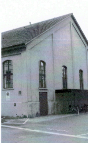
Reithalle Ost, Apfelhausenweg
